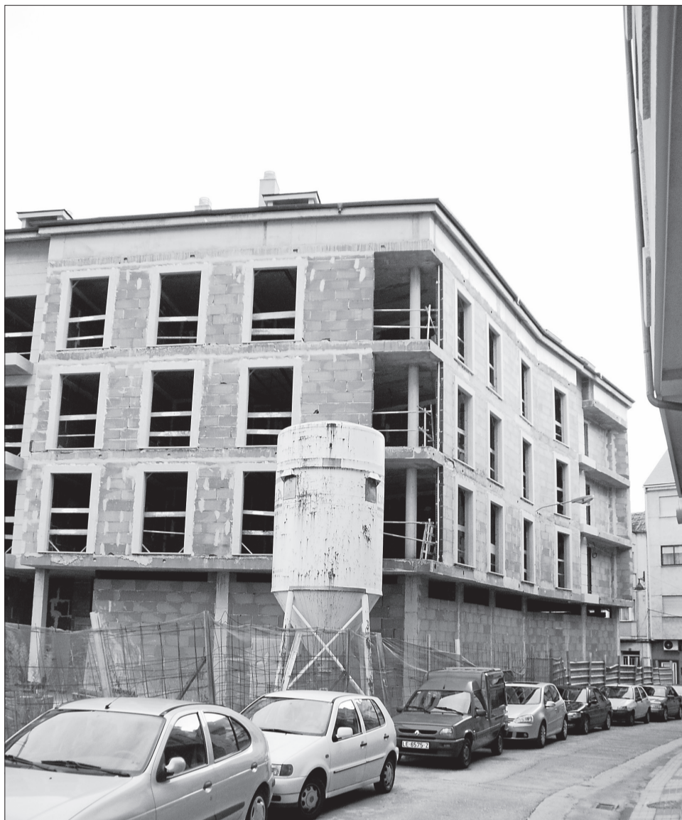
Edificio en construción na provincia de Ourense.
