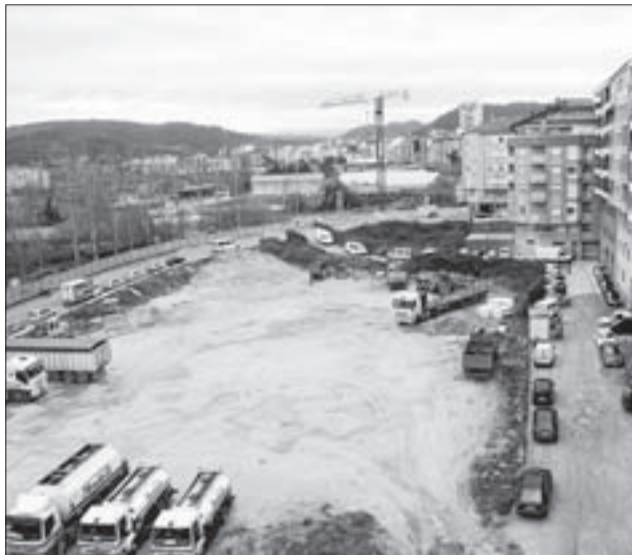
Terreos onde se construír o edificio.
