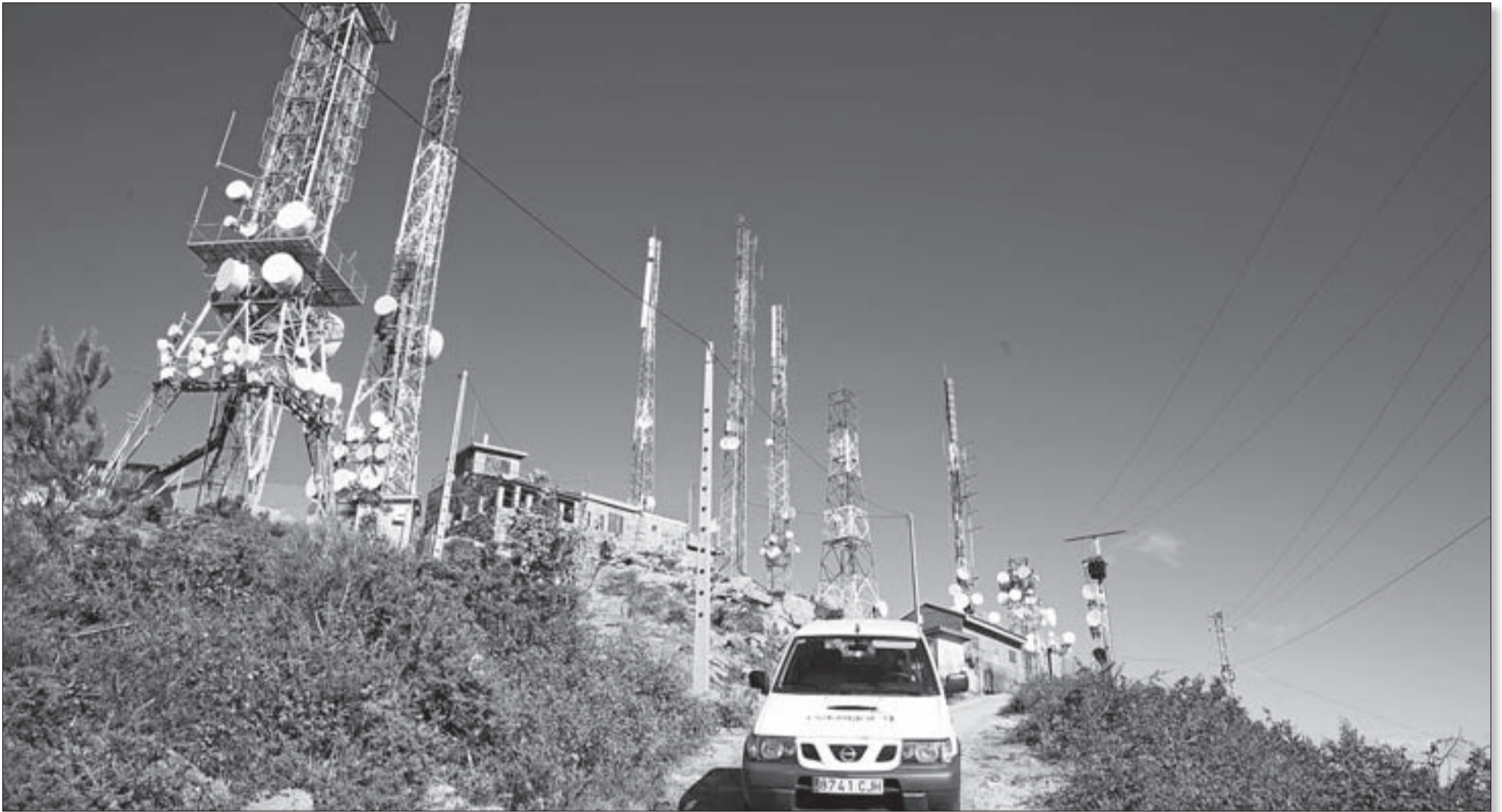
Actualmente en toda a comunidade hai instalados un total de 4.137 receptores de TDT-SAT.
